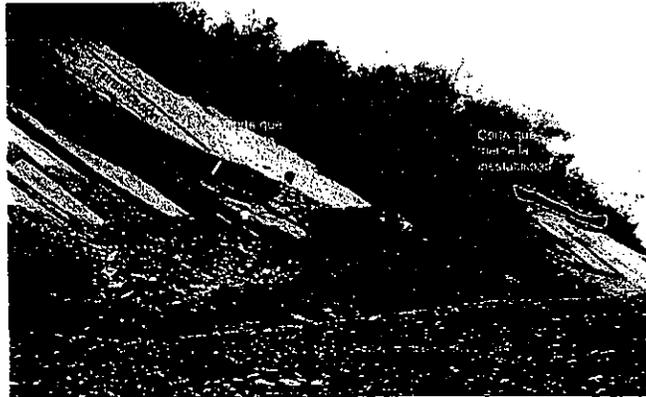
Fotografía 5. Inestabilidad de una ladera: tanto la inclinación de la ladera como la de la discontinuidad son paralelas; los cortes que se han efectuado aceleran el deslizamiento por falla plana de los estratos.
